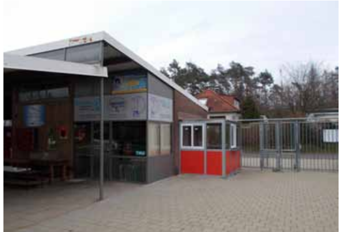
Das neue Kassenhäuschen ist fast fertiggestellt.
