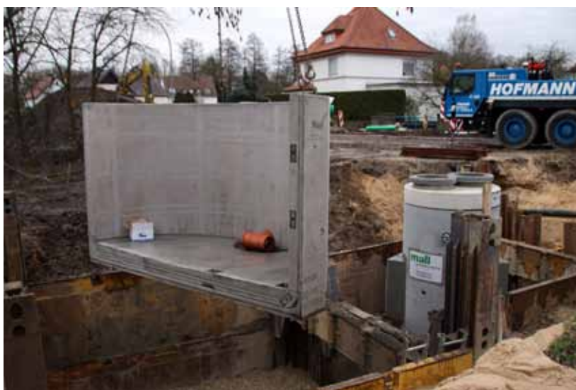
Montage des Klärbeckens. (Foto: Stadt Detmold)
